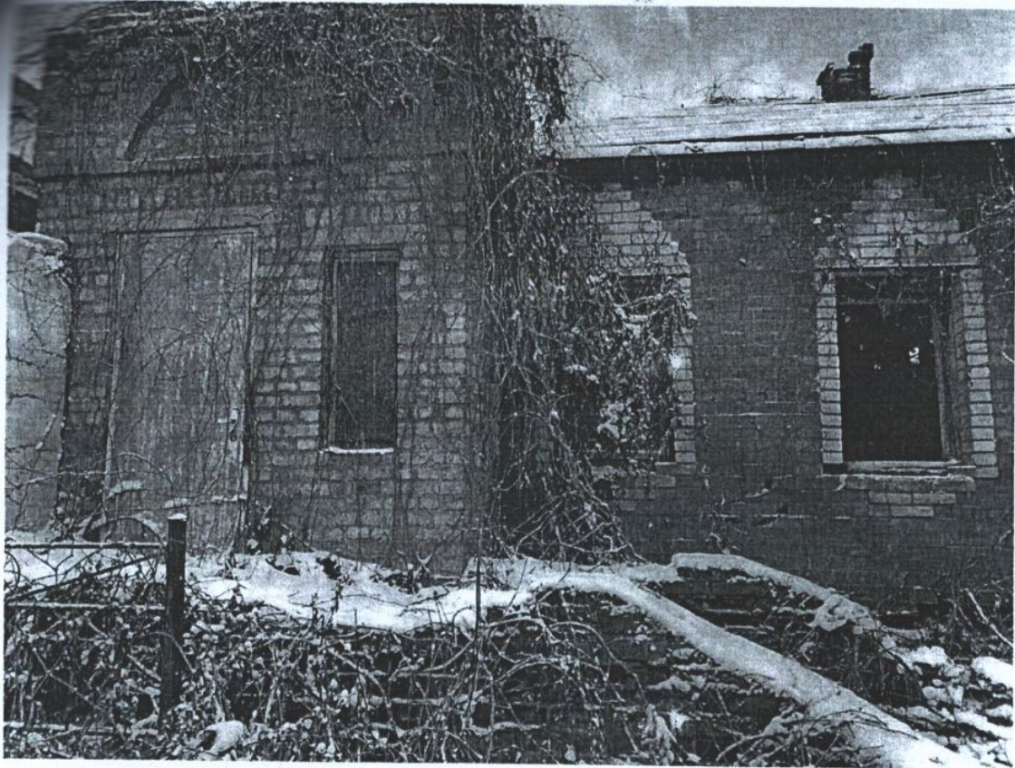
Фото 1. Загальний вигляд будівлі з головного фасаду
