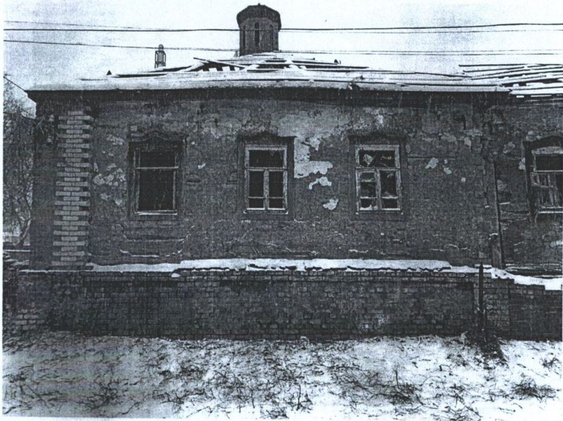
Фото 2. Загальний вигляд будівлі з бокового фасаду
