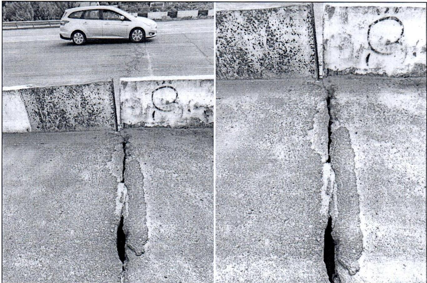
Ця руйнація шляхопроводу відбувається через те, що укіс шляхопроводу з боку вул. Шишкарівська не був укріплений ані бетонними плитами, ані поверхневим армованим бетонуванням! Крім того, не в повному обсязі виконано проектне рішення по відводу зі шляхопроводу та підходів до нього дощових вод, тому укіс постійно розмиває і у якийсь час його підмисє так, що перехідні плити просто впадуть у прірву. Фотофіксація після нетривалої зливи на початку червня додається.
