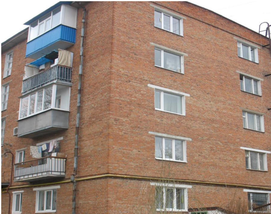
Рис. 5. Остеклення індивідуальних вікон та балконнів будівлі
