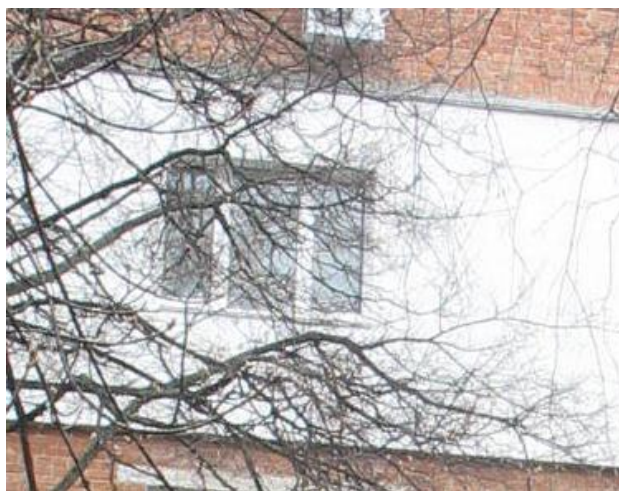
Рис. 3. Точкове утеплення стін будівлі.
