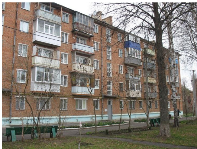
Рис. 2. Фасад будівлі. Орієнтація південно-східна.
