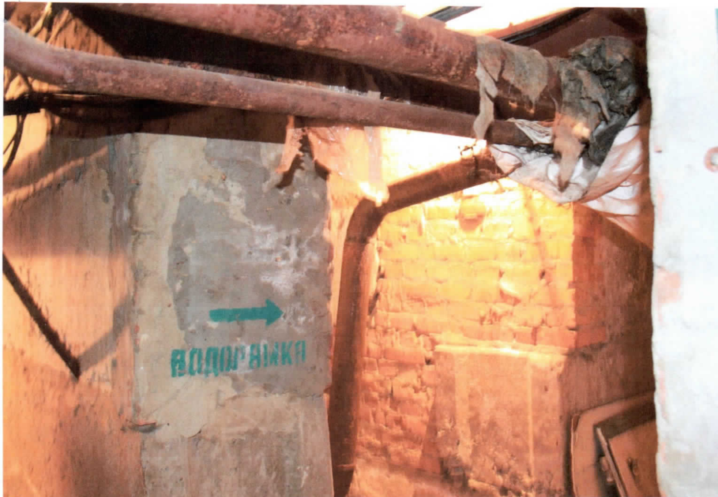
Прохід до водорамки
